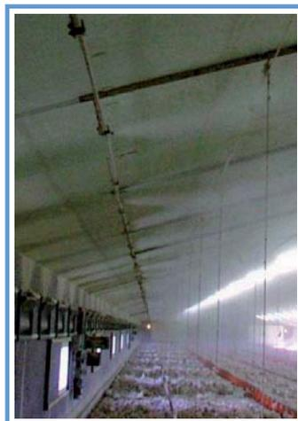
Sistema de refrigeración de la nave por micronebulización de agua a presión.
