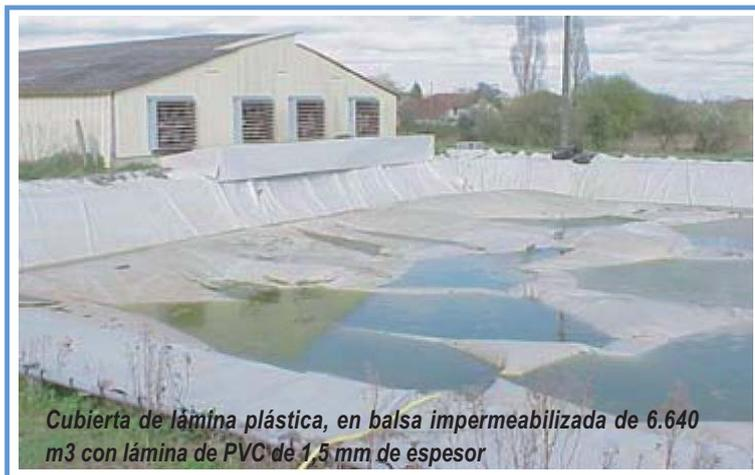
Cubierta de lámina plástica, en balsa impermeabilizada de 6.640 m<sup>3</sup> con lámina de PVC de 1,5 mm de espesor
