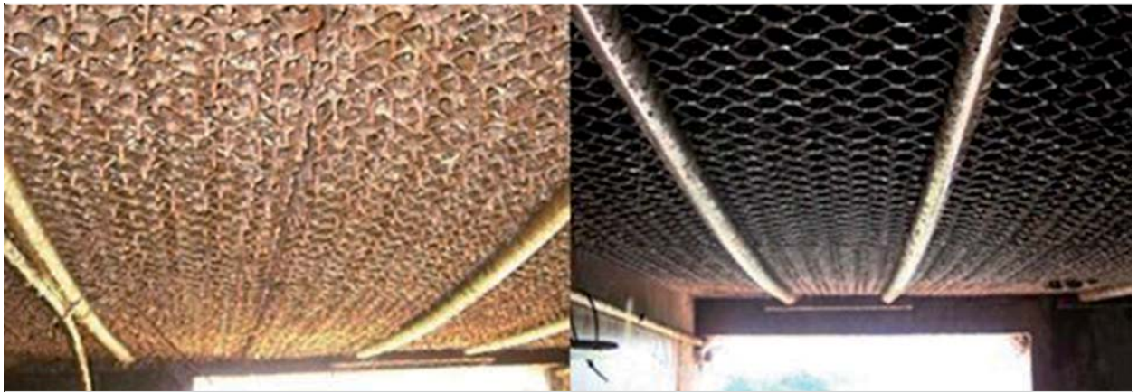
Figura 6. Presencia de biofilm en las torres de lavado. Mayo de 2013. Torre 2 (con biofilm, imagen izqda.), Torre 1 (sin biofilm, imagen dcha).
