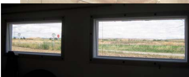
Malla pajarera en ventanas.
