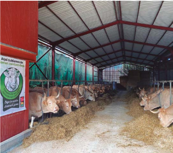
Pasillo de alimentación. Explotación de Gil Goyeneche de Arizkun
