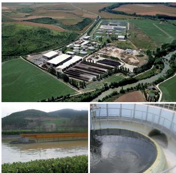
Vistas de la depuradora de Arazuri (Navarra)
