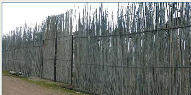
Cortaviento tradicional de la Ribera de Navarra, construido con cañas. Obsérvese que el acceso está dotado de puerta cortavientos.
