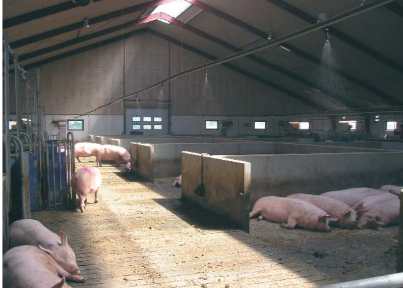
Sistema de refrigeración de nave.
