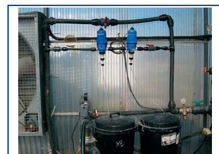
Sencillo cabezal de Fertirrigación, usado para la incorporación de la Solución Nutritiva.
