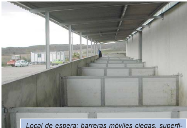
Local de espera: barreras móviles ciegas, superficies lisas, bien ventilado, con agua por aspersión.
