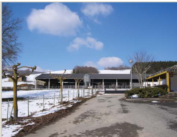
"Zona sucia" de las instalaciones: parking, oficinas y vestuarios y puerta motorizada.
