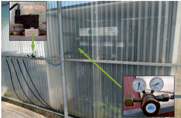
Bloque de gas con regulador de presión protegido en el exterior y electroválvula para la inyección automática a través del controlador climático en el interior del invernadero.
