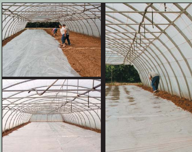
Colocación y tensado de de la lámina de plástico
