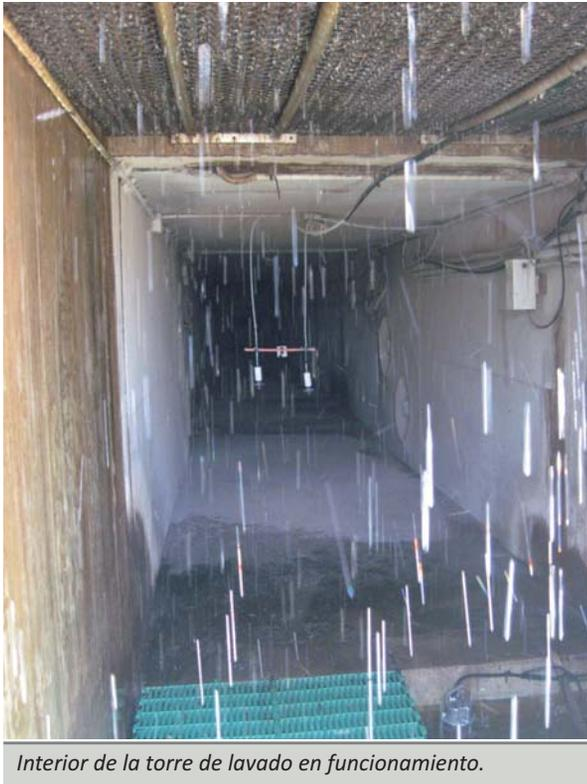
Interior de la torre de lavado en funcionamiento.
