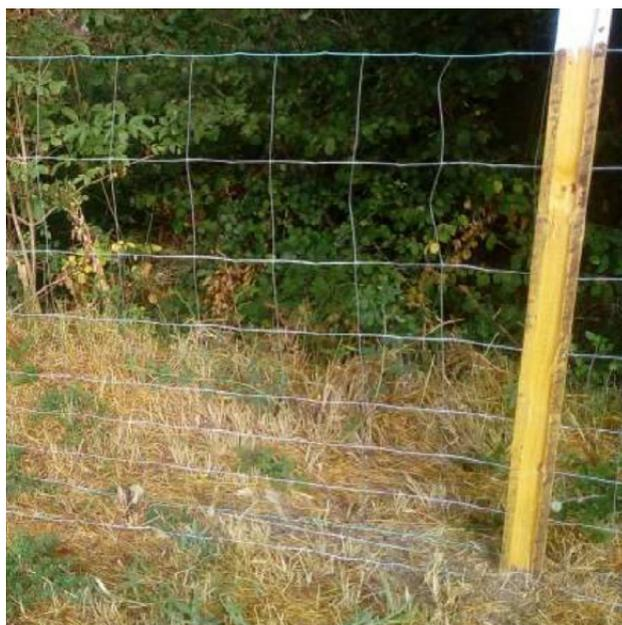
*Vallados no enterrados y sin zócalo precisan un control frecuente*
