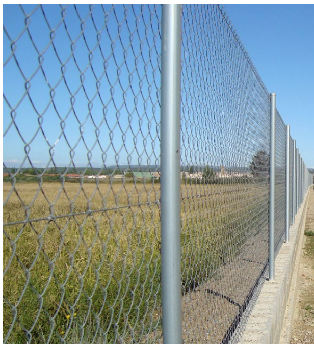
Vallado con zócalo
