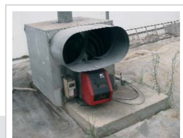
Detalle de calefactor por aire caliente. Finca de Sartaguda.
