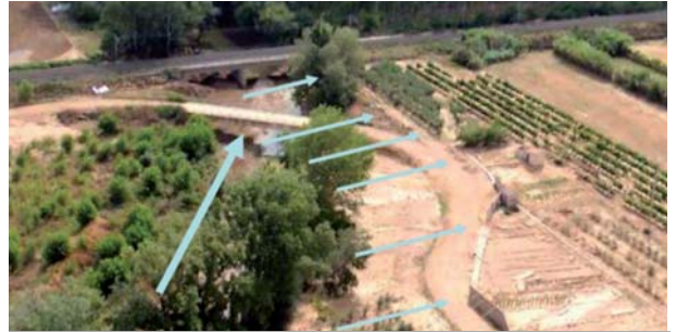
Desbordamiento del Cidacos en Olite por el efecto tapón del Puente de Hierro. Fuente: Gobierno de Navarra
