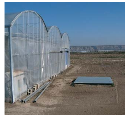
Depósito exterior enterrado para recoger los lixiviviados por gravedad. (Finca Sartaguda)
