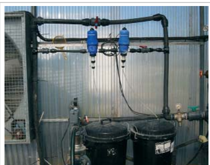
Cabezal mínimo a instalar. Útil para explotaciones hasta 4.000 m 2 . (Finca Sartaguda)
