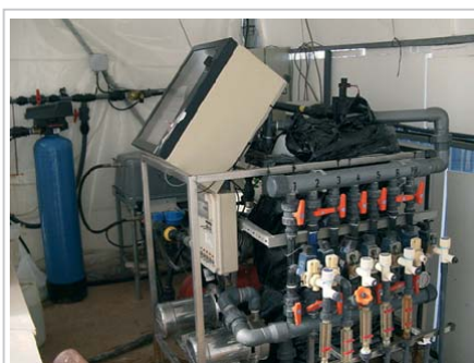
Es preferible contar con un cabezal automático con control de conductividad y pH de la solución nutritiva. (Finca Sartaguda)
