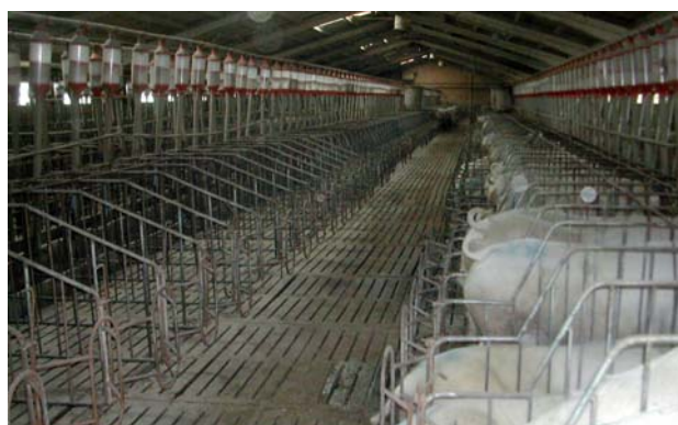
Nave antes de la obra.
