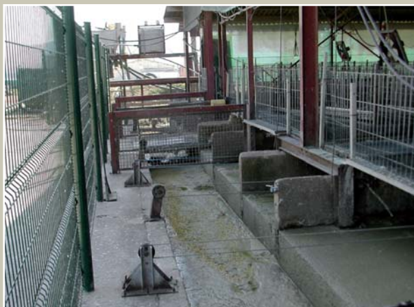
Arrastrador mecánico bajo emparrillado, permite el vaciado frecuente de las fosas. De este modo el purín está menos tiempo en contacto con el aire, emitiendo gases.
