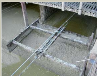
Arrastrador mecánico bajo emparrillado, permite el vaciado frecuente de las fosas. De este modo el purín está menos tiempo en contacto con el aire, emitiendo gases.
