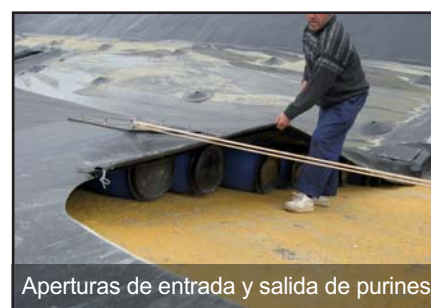
Cubierta con lámina plástica
