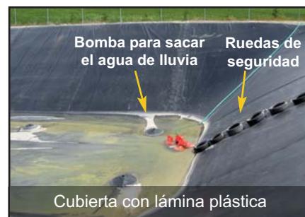
Cubierta con lámina plástica
