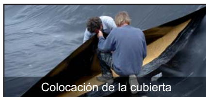
Colocación de la cubierta
