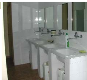
Cuenta con zona de duchas y aseos para los trabajadores.
